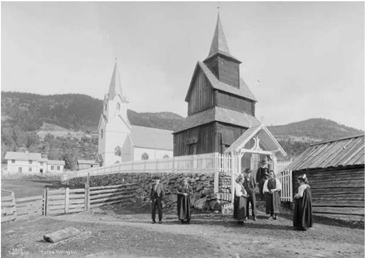
Fig. 26: Fotografi fra slutten av 1800- tallet som viser den nye kirken på Torpo bygget i 1880 ved siden av Torpo stavkirke. Den nye kirken er bygget i klassisistisk stil, noe som kjennetegnet mye av kirkene som ble reist på 1800 -tallet (Torpo stavkyrkje, 2005)
