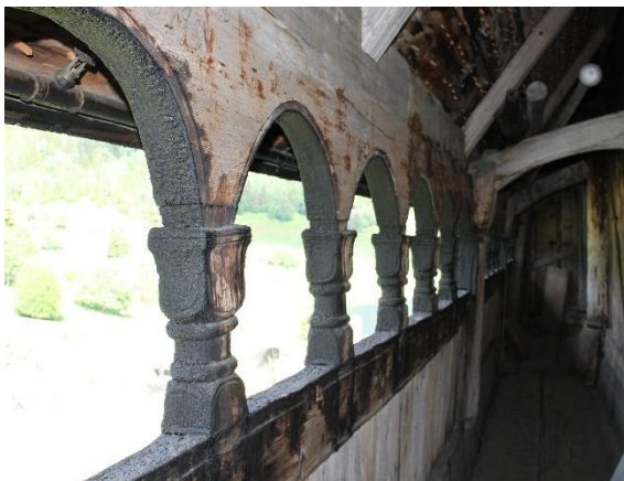
Fig.17. Svalgangen sett innenfra.
